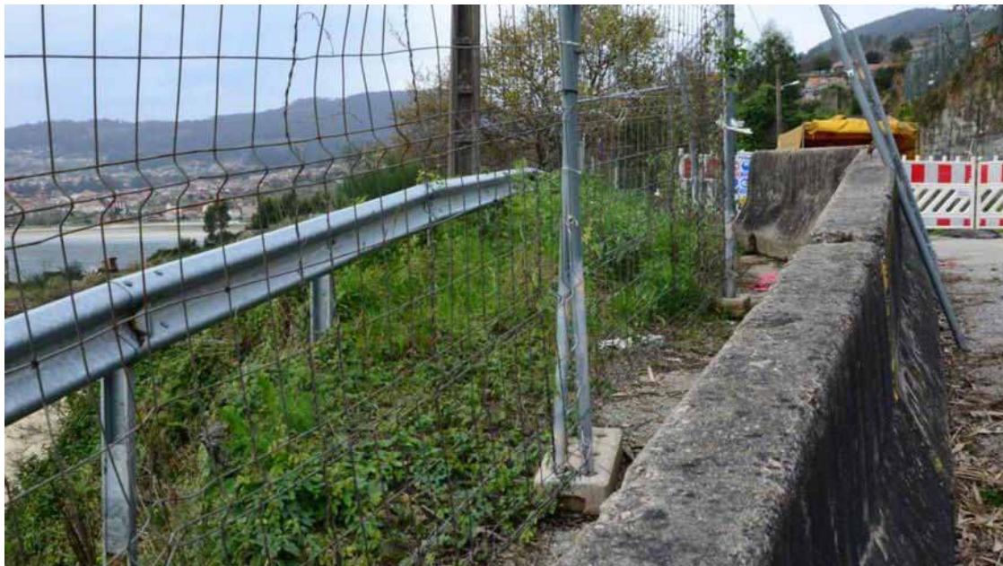
Zona de O Cocho vallada para las obras. | // GONZALO NÚÑEZ / Cristina González
